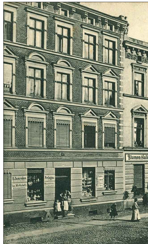
Zdjęcie archiwalne : widok elewacji frontowej na pocztówce z roku około 1909, źródło: www.fotopolska.eu
